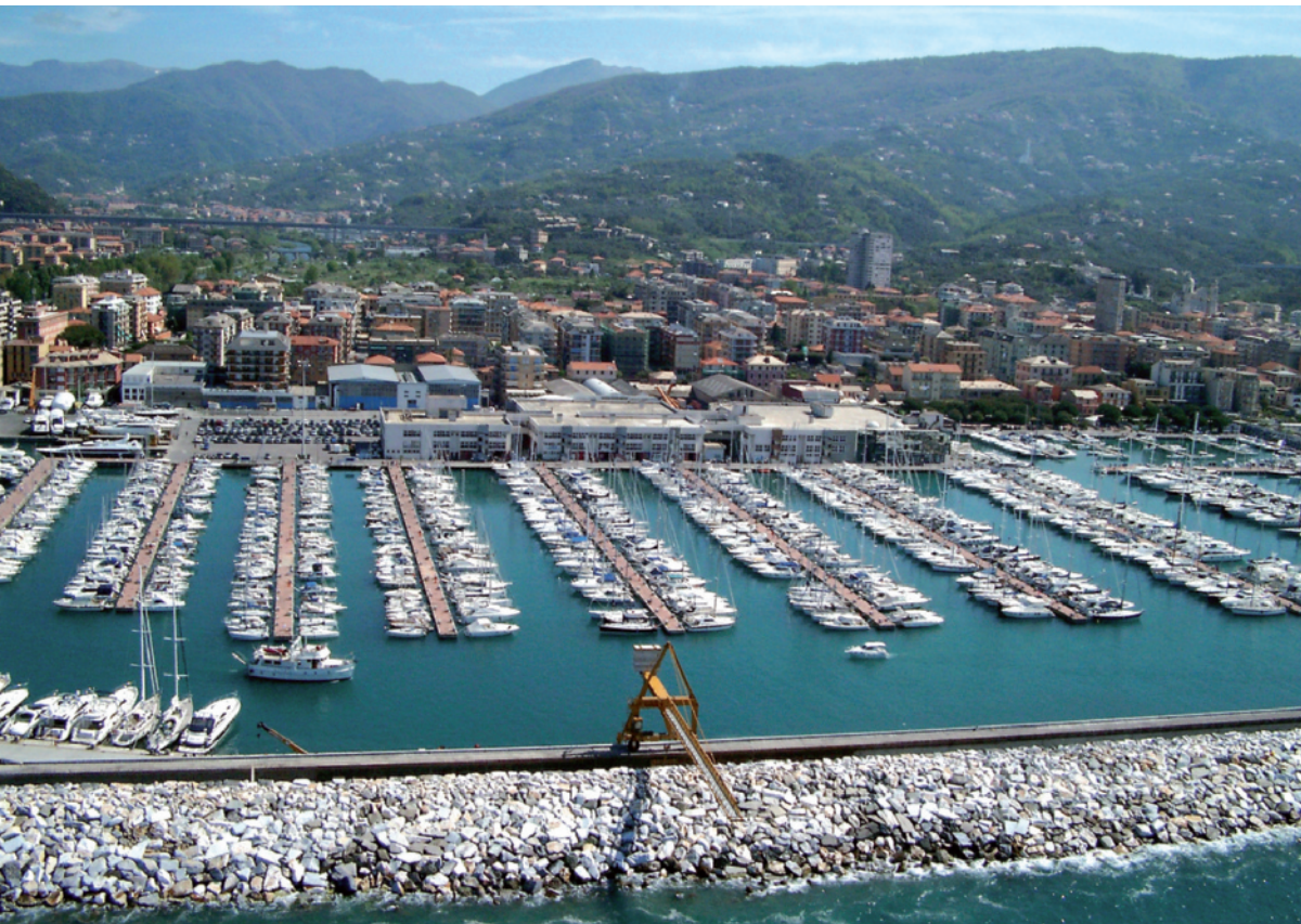
2005: lavori in corso in diga
